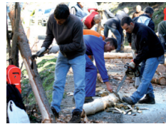
Preparant les falles. En primer pla treient l'escorça del tronc que es convertirà en falla. Darrera, dos joves preparant els tascons a partir de branques de bedoll
